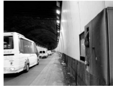
Uno de los puntos con teléfonos de emergencia del túnel
