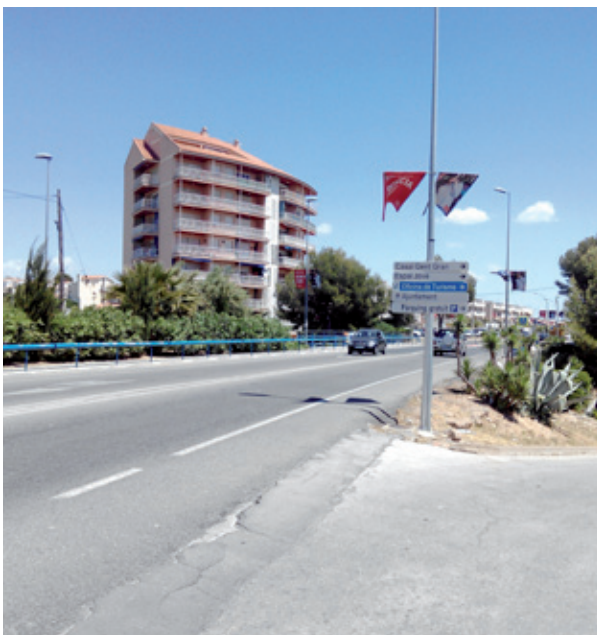
Tram sense vorera (costat sud del pont)
