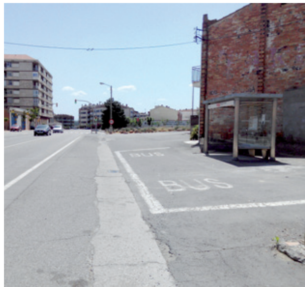
Parada de bus amb marquesina sense vorera per accedir-hi
