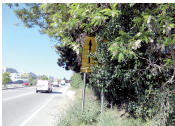
Senyalització en mal estat
