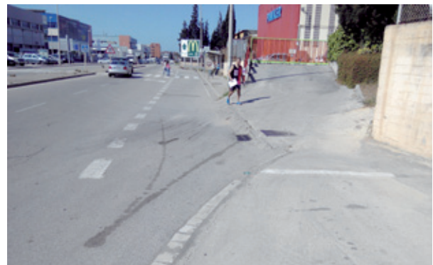
Espai d'aproximació que permet l'accés de l'autobús a la parada sense interrompre la circulació de vehicles.
