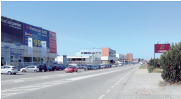
Tram situat a l'oest sense cap pas de vianants.
