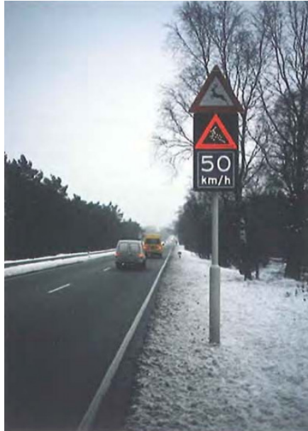
Figura 26.- Sistema de aviso con sensores térmicos utilizado en Suiza, en un tramo en el que los ciervos acostumbran a cruzar la carretera. (Foto de H. Bekker). [Fuente: MMA]
