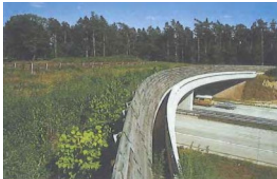
Figura 32.- Ecoducto de Boerskotten en el que se muestra una pantalla hecha de madera. Las pantallas tienen que estar tan cerca de los extremos del puente como sea posible. La barandilla paralela a la pantalla se ha diseñado para poder realizar de forma segura las labores de mantenimiento en Holanda. (Foto de H. Cormont). [Fuente: MMA].
