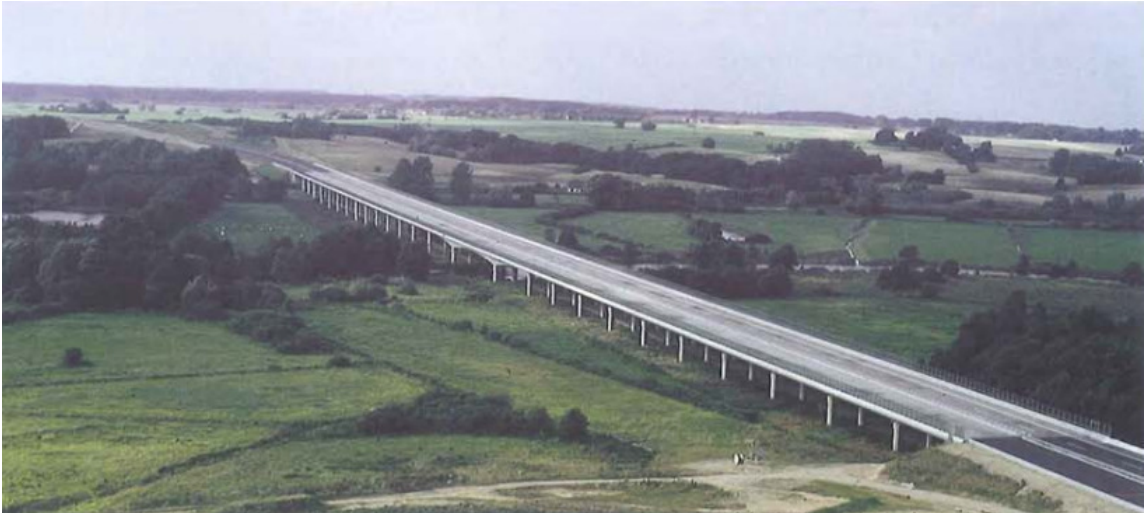
Figura 38.- Viaducto construido en la autovía A20, en el noroeste de Alemania. (Foto de DEGES). [Fuente: MMA]
