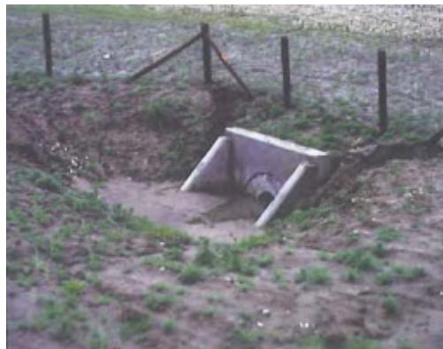
Figura 40.- Este paso ha quedado parcialmente inundado y colmatado con arena. La lección aprendida de este ejemplo es que los pasos deben estar construidos por encima del nivel del acuífero y que sus accesos deben tener pendientes estables, que no puedan resultar afectadas por la erosión. (Foto de H. Bekker). [Fuente: MMA]
