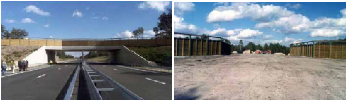
Figura 30.- Paso superior con vallado de madera para atenuar el ruido y las luces utilizados en Francia
