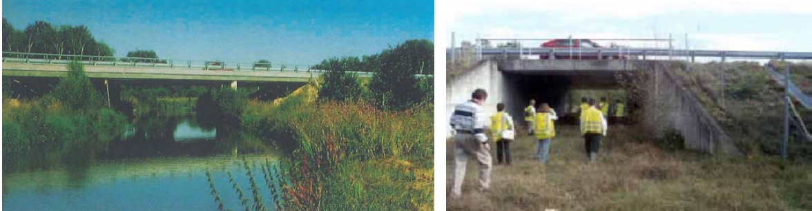
Figura 35.- Viaducto que permite conservar el lecho natural del río y también márgenes secos que facilitan el desplazamiento de los animales terrestres (izquierda) y paso inferior de fauna (derecha).
