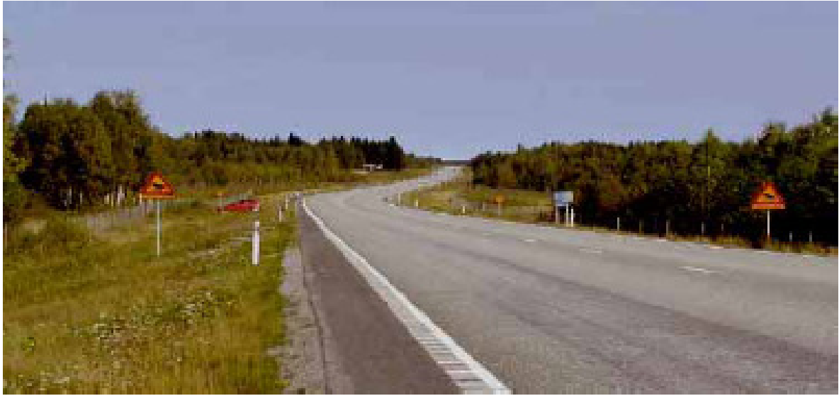
Figura 46.- Ejemplos de Sistemas de detección de animales y de advertencia de peligro utilizado en Suecia
