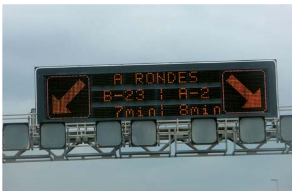
Senyal variable a l'entrada de Barcelona venint de l'AP-2 on s'indica el temps de viatge segons l'alternativa escollida.
