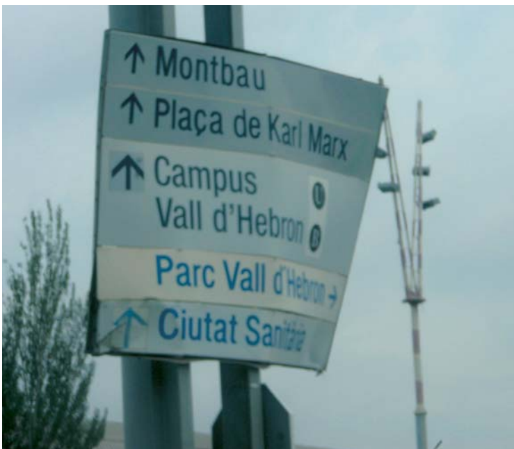
Senyal ubicat a les proximitats de l'Hospital de la Vall d'Hebron que presenta un deteriorament important per un manteniment inadequat.
