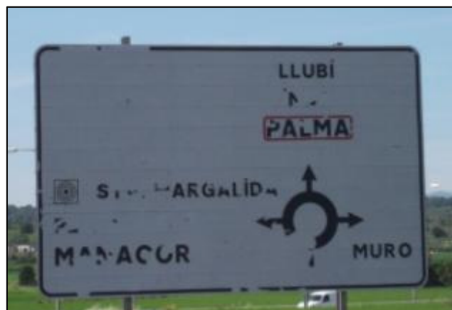
Senyal a la carretera PM-341 on el desgast no permet percebre la major part de destins
