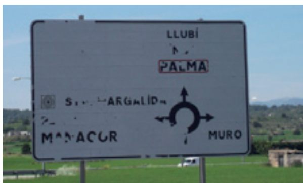
Senyal a la carretera PM-341 on el desgast no permet percebre la major part de destins.
