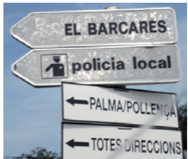
Senyal a la carretera PM-341 on el desgast no permet percebre la major part de destins.
