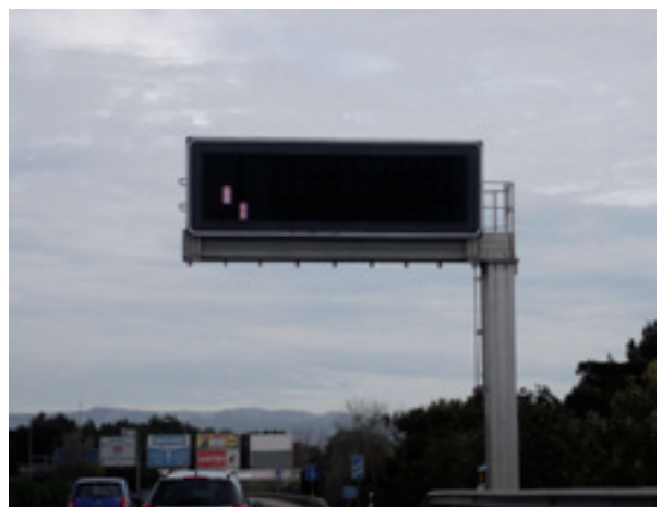
Un dels molts pòrtics observats a la xarxa viària mallorquina que no es troben en funcionament.
