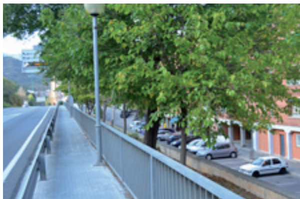
Barreres de protecció de via interurbana
