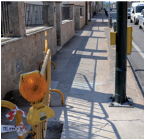
Amplada útil de vorera inferior a 1m i amb un estat irregular.
