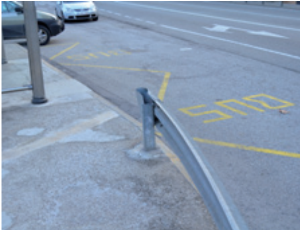
Parada de bus accessible en el sentit nord de circulació
