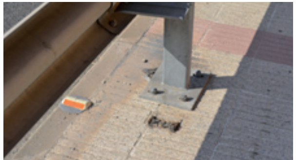
"Ulls de gat" que destaquen els límits del carril de circulació.
