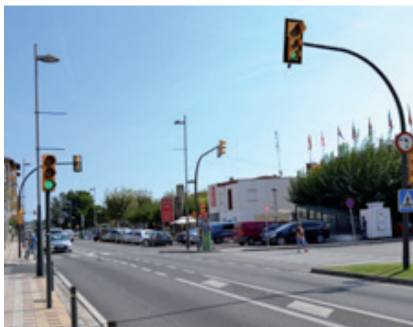
Intersecció semaforitzada i la separació de marques vials.
