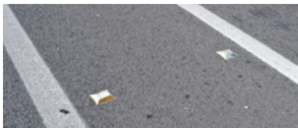
"Ulls de gat" destacant els senyals de separació de carrils.
