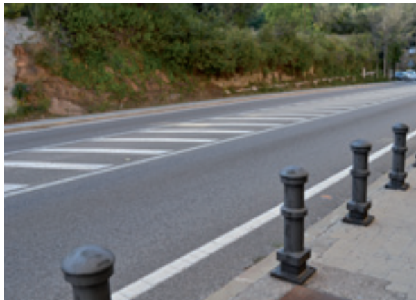
Pilones protectores de la vorera
