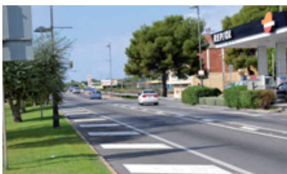
Entrada difusa amb mesures de moderació de trànsit, però inexistència de voreres
