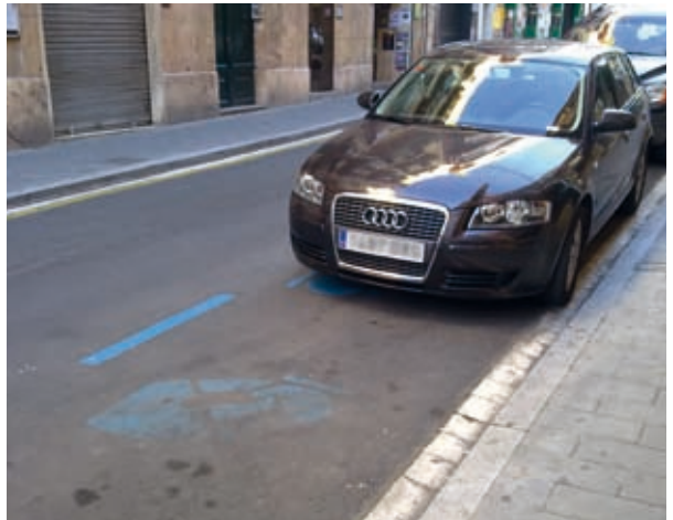
Símbol de Zona blava amb manteniment deficient.
