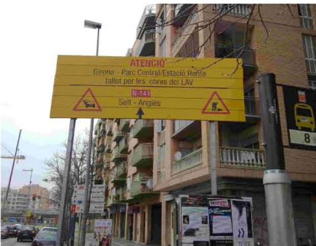
Senyalització vertical d'avís per a vehicles a motor en els 500 metres previs a l'inici de les obres (des del carrer d'Emili Grahit)
