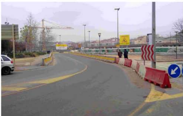
Elements de protecció previs al desviament des del Passeig d'Olot
