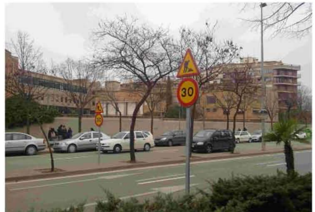
Senyalitzacions verticals de perill per obres, i reducció de velocitat prèvia al tram d'obres. Accés des de l'Avinguda d'Olot
