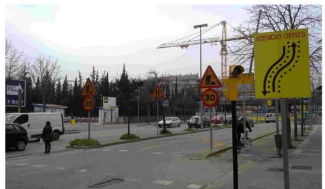
Senyalitzacions verticals de perill per obres, i estretament del vial, i reducció de velocitat prèvia al tram d'obres. Accés des de Emili Grahit
