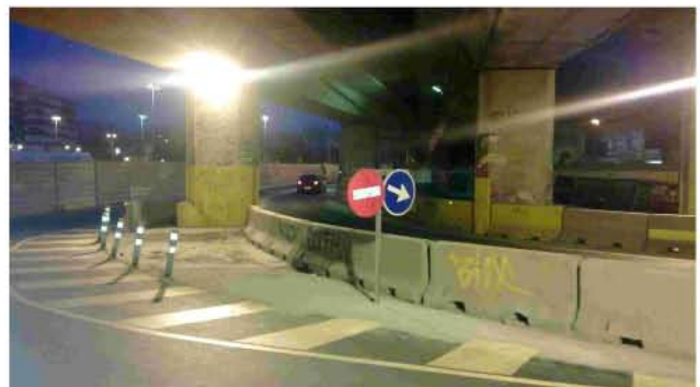
Enllumenat dins de l'espai d'obra
