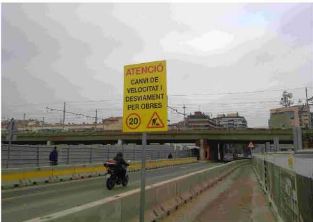
Senyalitzacions verticals de perill i de reducció de velocitat per a vehicles a motor en el tram d'obres
