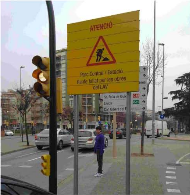
Senyalització vertical d'avís per a vehicles a motor d'avís en els 500 metres previs a l'inici de les obres (des del Passeig d'Olot)
