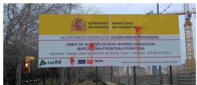
Plafó informatiu de l'obra que s'està duent a terme
