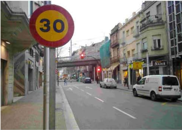
Avís de reducció de velocitat al carrer de Santa Eugènia en les proximitats de les obres
