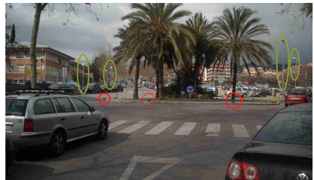
Elements reflectants en l'anella interior (vermell) i fanals en l'exterior (verd) de la rotonda urbana
