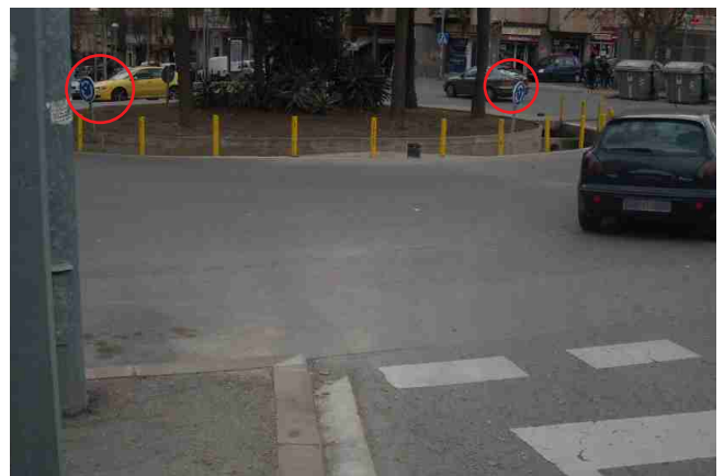
Senyals R-402 compartides entre els accessos N, NE i E a la rotonda urbana
