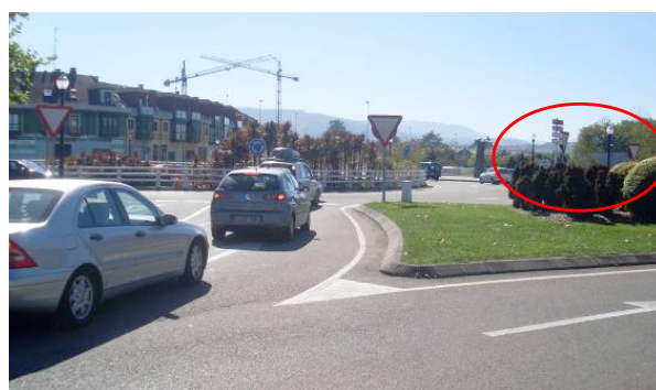
Vegetación en las isletas que dificultan la visibilidad (Glorieta 3)
