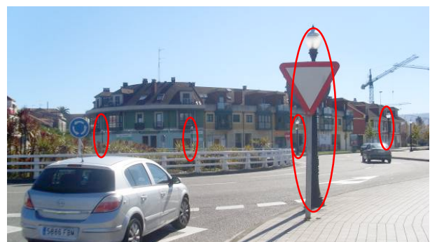
Farolas inadecuadas en el anillo exterior (Glorieta 3)
