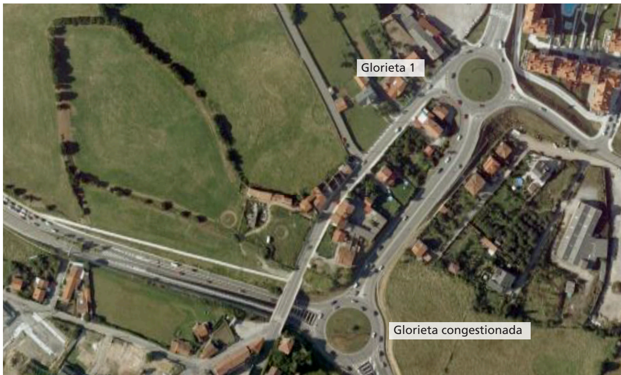
Transferencia de congestión entre la glorieta 1 y la glorieta de acceso a la AS-1.
