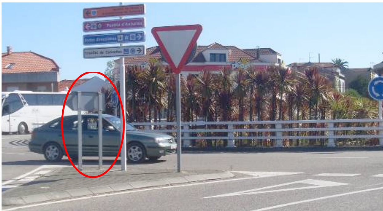
Señalización de más de un metro de altura dificulta la visibilidad (Glorieta 3)
