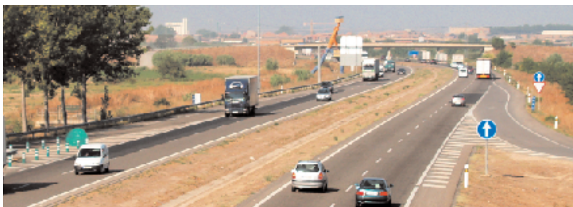
Autovia amb mitjana sense sistemes de contenció
