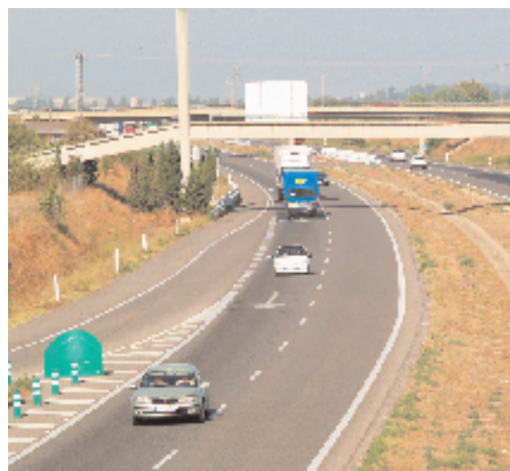
Carril de desacceleració
