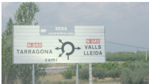
Senyal "incomplet" on degut a una falta de manteniment ha perdut diverses lames del seu contingut.
