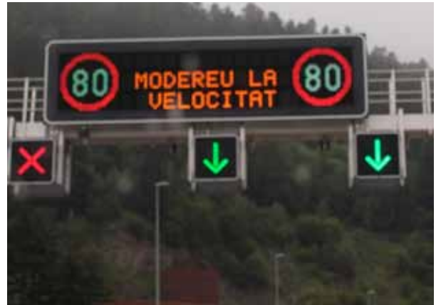
Senyalització variable en pòrtic que pot informar d'incidències dintre un túnel o gestionar el trànsit del mateix
