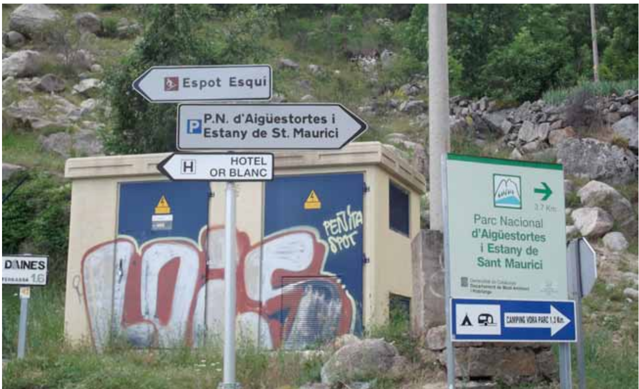
Superposició de senyals a la cruïlla entre la carretera d'accés a les pistes d'esquí d'Espot i de l'entrada del Parc Nacional d'Aigüestortes.
