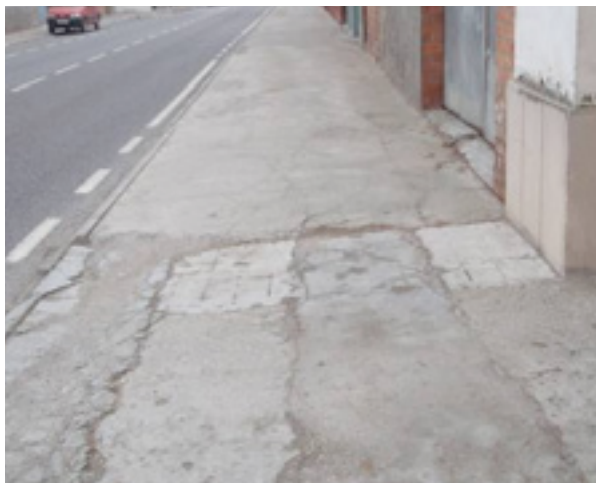
Trams de vorera estrets i en mal estat.
