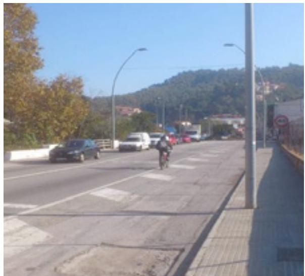
Bandes rugoses i voral ample a l'accés est de la travessera de Vallirana.
