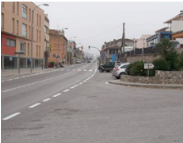
Punt de la travessera amb vorera i pas de vianants inexistent.
