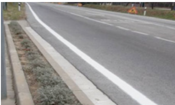
Elements de mobiliari urbà i zona de parterres que separen vorera i calçada.
