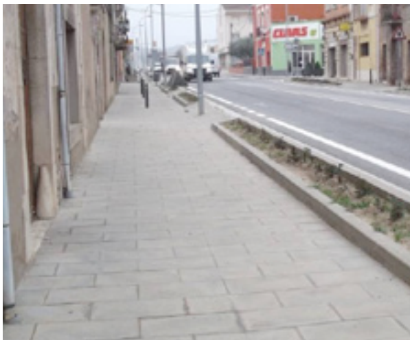
Tram de travessera amb una amplada lliure superior als 3m.
