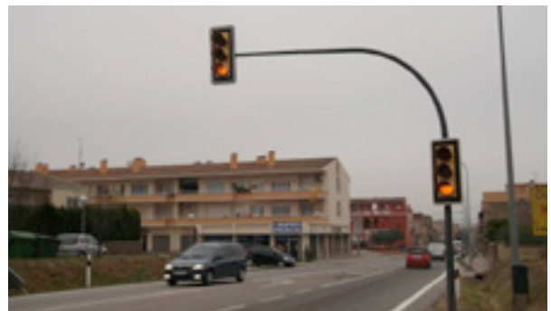
Semàfor regulador de velocitat a l'accés sud de la travessera.
