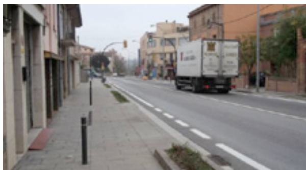
Zona d'aparcament a la travessera i mobiliari urbà i vegetació que ho impedeix.
