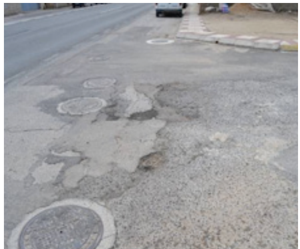
Paviment en mal estat.
