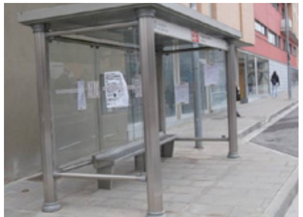
Marquesines de les dues parades de la travessera.
