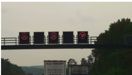
La cámara de abordado “ve” barras negras moviéndose a través de los paneles de señalización, lo que dificulta el reconocimiento.
